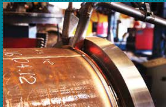
Автоматическая сварка под флюсом
