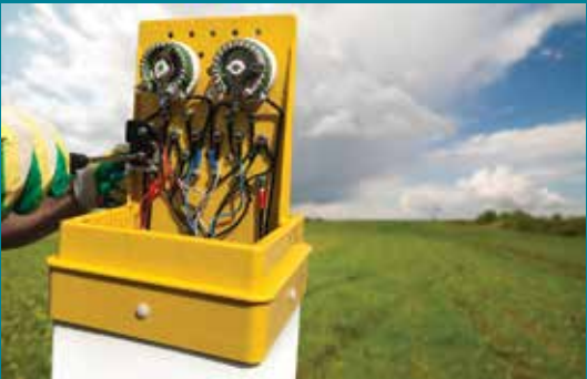
Монтаж кабелей на клеммной панели
