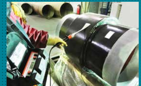
Проверка диэлектрической сплошности наружного покрытия
