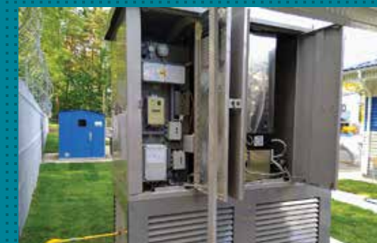
ПЭКЗ с питанием от термоэлектрогенератора
