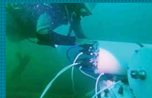
Пуско-наладочные работы на газопроводе «Джубга-Лазаревское-Сочи»
