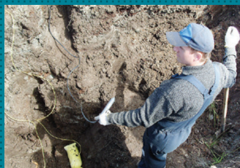
Монтаж ПКМ-ТСТ-КонтКорр®-ИСК
