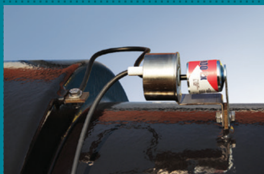
Датчик МКИ на искроразряднике
