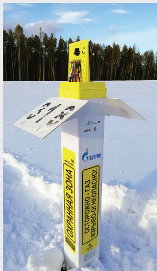
КИП на 318-ом километре газопровода Сила Сибири
