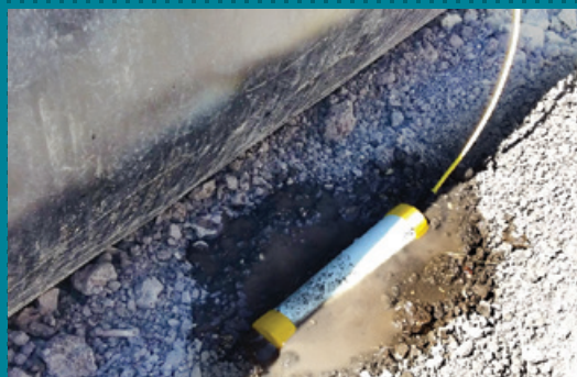
Монтаж электрода сравнения
