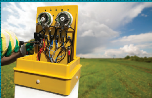
Монтаж кабелей на клеммной панели
