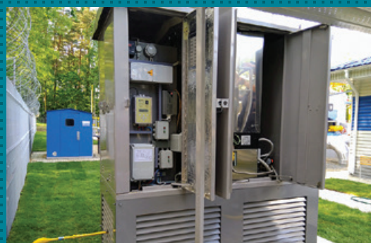
ПЭКЗ с питанием от термоэлектрогенератора
