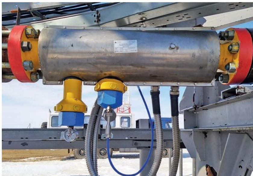
Рис. 2. Система коррозионного мониторинга в составе трубопровода обвязки газоконденсатной скважины № 2А142
